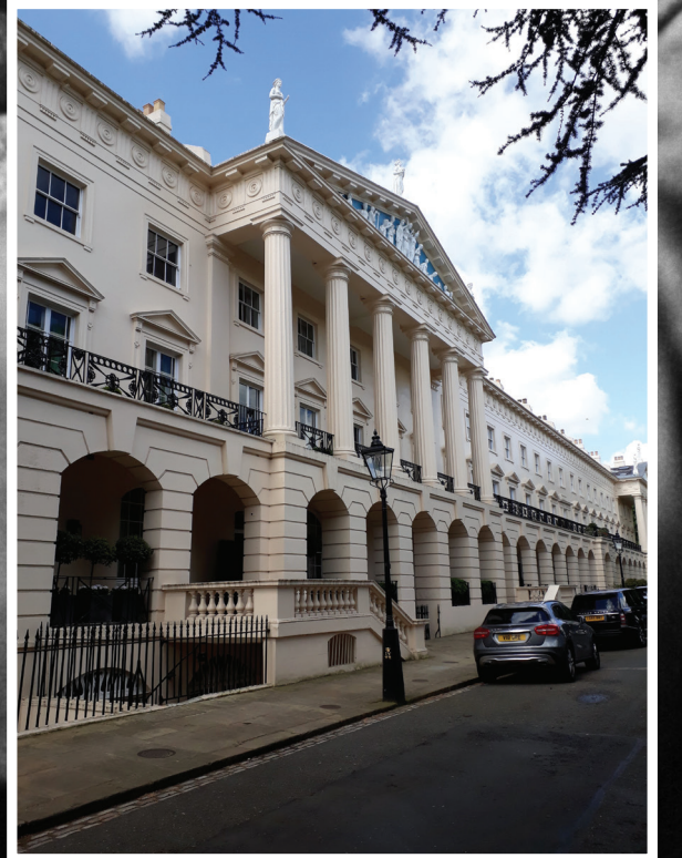
Günümüzdeki hâliyle Hanover Terrace (Fotoğraf: Emre Aracı)
