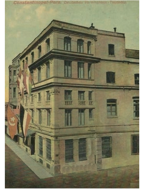
Beyođlu'ndaki Alman Derneđi Teutonia'nın binası
